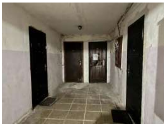
5.stāva kāpņu telpa
