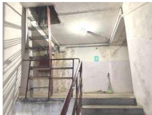
5.stāva kāpņu telpa
